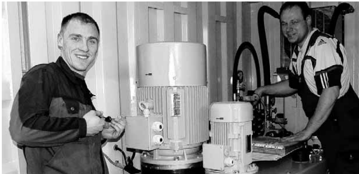
Assfalg-Mitarbeiter Andreas Gaus (links) und Albert Traub arbeiten an der Hydraulik zu einem mobilen Wasserkraftwerk.
