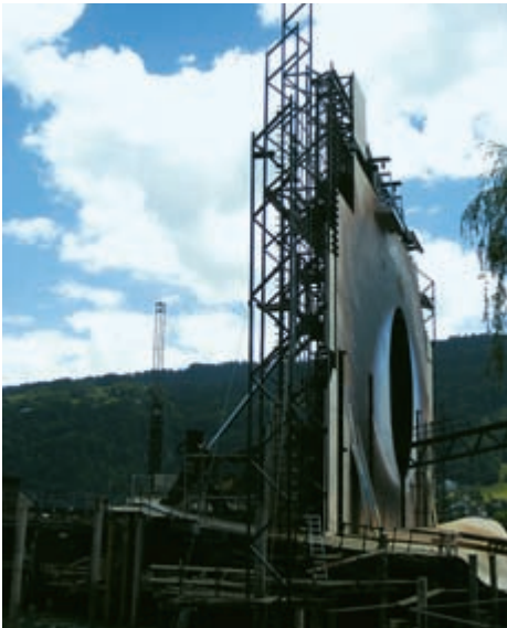
Die Seebühne in hochgeklappter Endphase: rund 25 m Höhe, 50 m Breite, 150 Tonnen.
