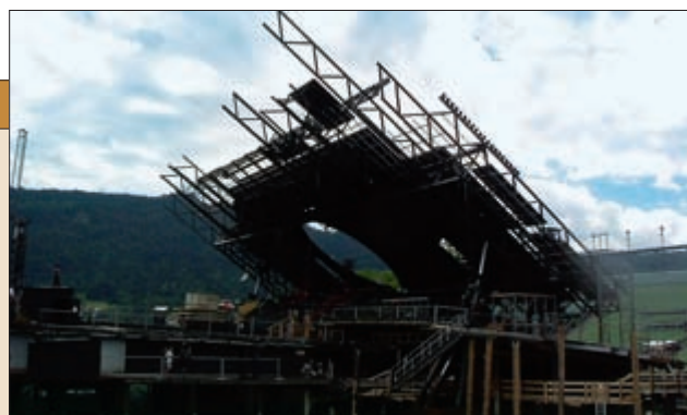
Die Seebühne während des Klappvorganges: mittig links und rechts die beiden Hauptzylinder.
